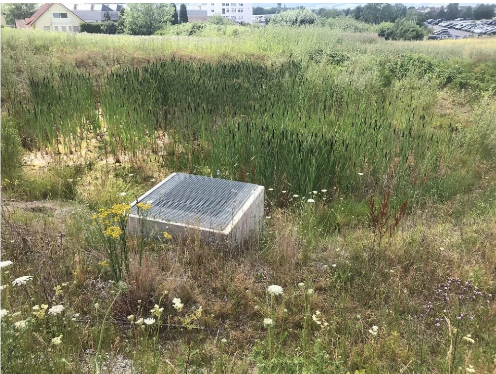
Abb. 13: Regenrückhaltebecken nordöstlich in Gebiet 2
